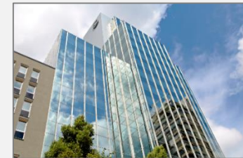
OFFICE, Bleichstrasse, Frankfurt Main
